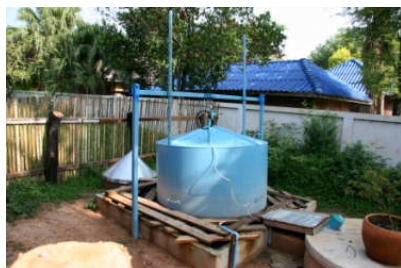
エコトイレからのガス収集システム
