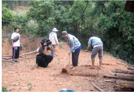
ホイプム村トイレ掘削作業
